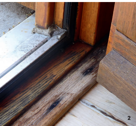
Südfassade: Balkontür mit Schimmelpilzbefall
