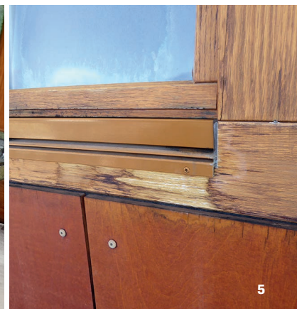
Nordfassade: Detail Fenster mit Spuren von Kondensat
