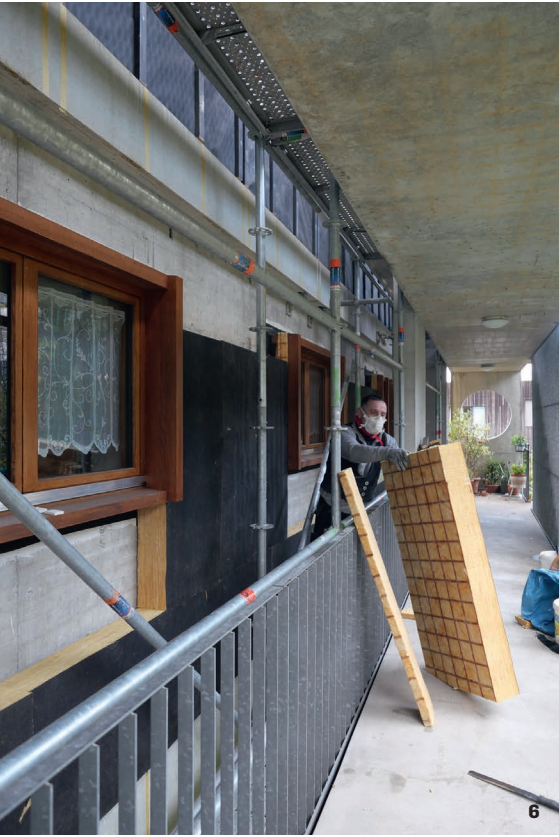
Montage Fassade Nord
