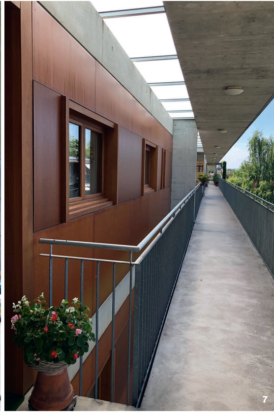
Laubengang Nord mit Oblichtverglasung
