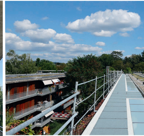
Flachdach mit Glasoblicht und Photovoltaik
