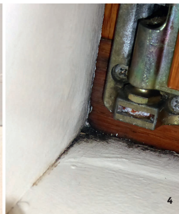
Nordfassade: Fensterrahmen mit Schimmelpilzbefall
