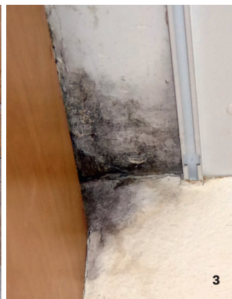
Südfassade: Rahmenverbreiterung mit Schimmelpilzbefall
